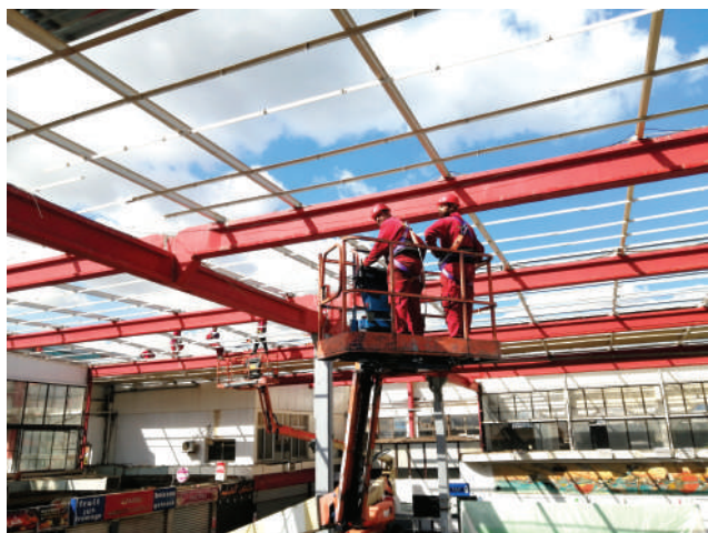
Travaux d'Etanchéité Gare Routière Caroubie SOGRAL
